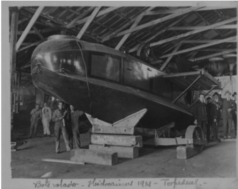
Figura 10. El bote volador Felixstowe F2A N, en su proceso de armado en la Base Las Torpederas, 1921. Fuente: Museo Marítimo Nacional. Archivo y Biblioteca Histórica de la Armada de Chile.
