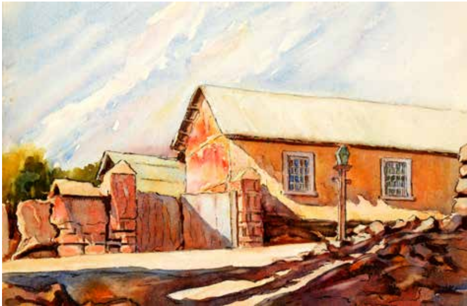
Imagen 5. Acuarela de Osvaldo Ramírez (Mr. Rou). (Archivo del Museo Histórico Gabriel González Videla). Pabellones de viviendas, 1963. Demolidas en 1976. Se ubicaban en el callejón Lambert (actual av. Islón), entre las calles La Gruta y Nazareno.
