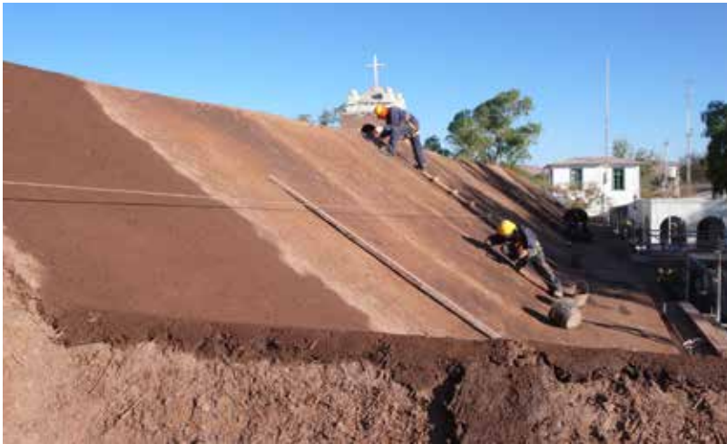
Figura 5. Aplicación de torta de barro. (Camilo Giribas, 2015)
