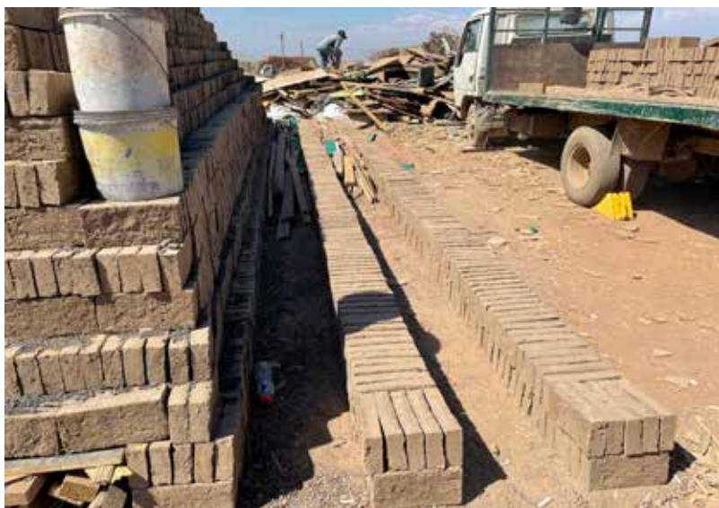
Figura 4. Construcción del horno con troneras que se llenan de madera reciclada. (Fotografía de autores)
