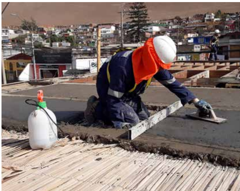
Figura 10. Aplicación de torta de barro. (Camilo Giribas, 2019)
