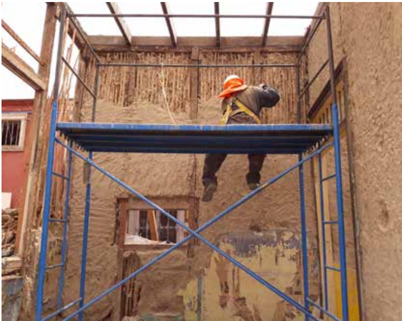
Figura 9. Desarme controlado de quincha. (Camilo Giribas, 2019)
