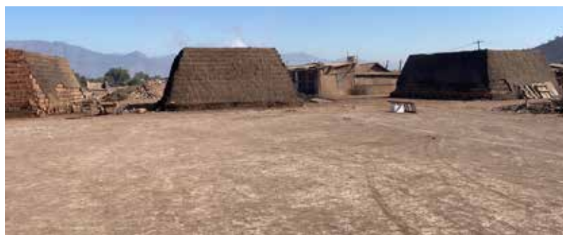
Figura 5. Enfriamiento de ladrillos con descascaramiento de la parte superior. (Fotografía de autores)
