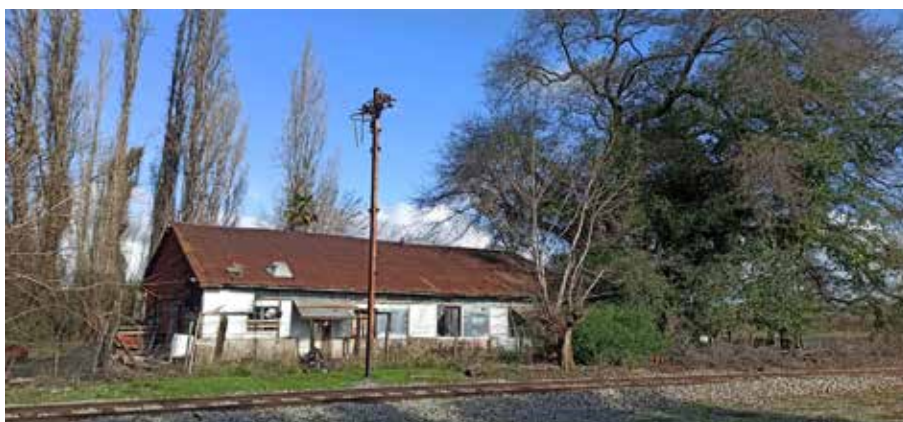
Imágenes 5 y 6. Levantamiento topográfico (planta) de la estación Colliguay (1992) y estación Colliguay (agosto de 2023). (Archivo EFE y archivo de los autores)
