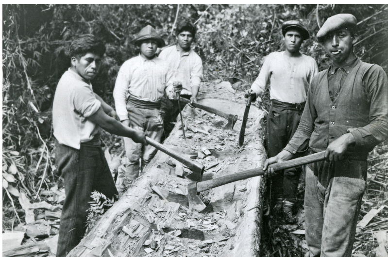
Figura 1. Construcción de embarcación monóxila en la selva aysenina, s. f. Museo Regional de Aysén, Colección L. Ludwig, n.º inv. D000693.
